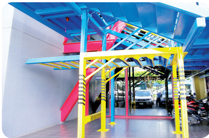
Escaleras de Emergencia.
